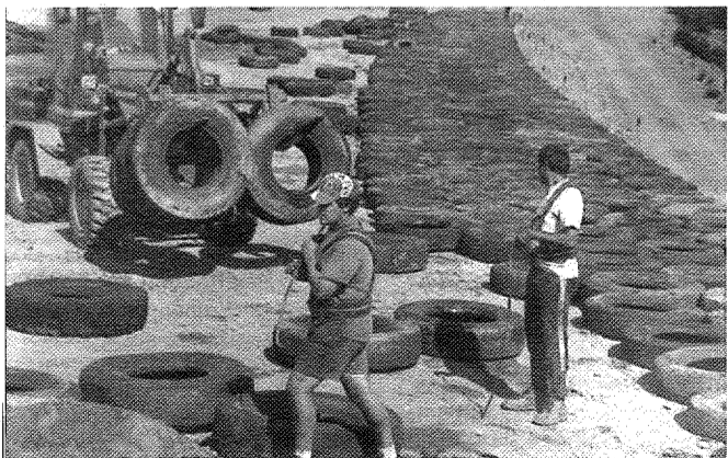
Sur la RN 124 entre l'Île-Jourdain et Pujaudran, un mille-feuilles de 18 couches de pneus et de terre : 20 000 pneus ont été nécessaires au remblai qu'imposait le chantier de la DDE.
