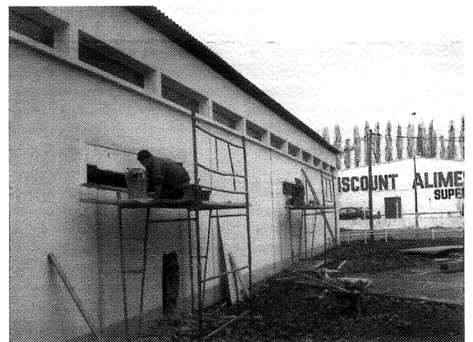
Des travaux d'aménagement pour le futur bazar discount.
