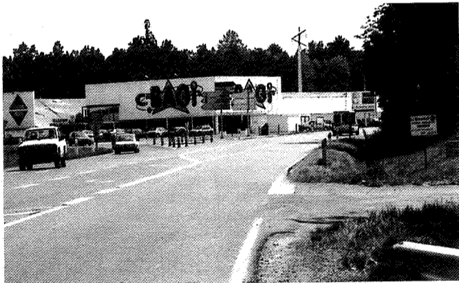
Sur ce site, le futur carrefour giratoire de Pavie.
